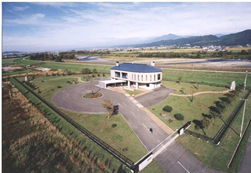
中五区水源送水場
