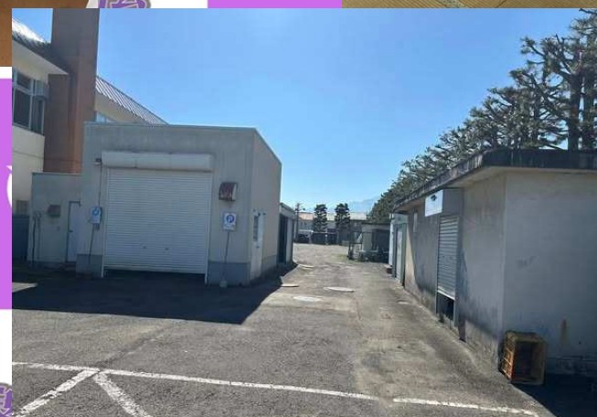
建物裏側の臨時駐車場への通路
