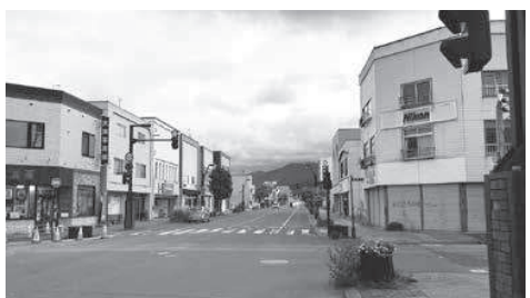
来年度からの工事が予定される東5条3丁目
