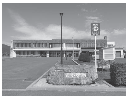
空調設備が導入された東小学校
