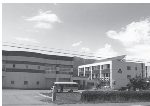
空調設備（エアコン）が設置された小学校
