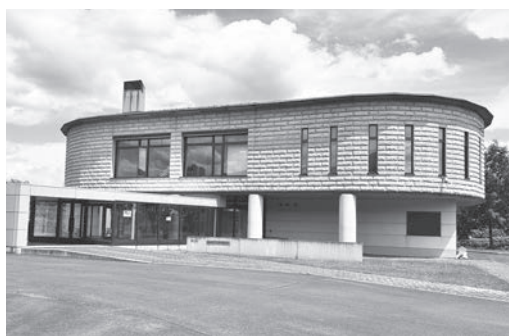
耐震化が求められる施設のひとつ 富良野市上水道水源送水場
