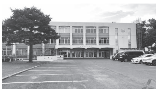
空調設備が設置された西中学校
