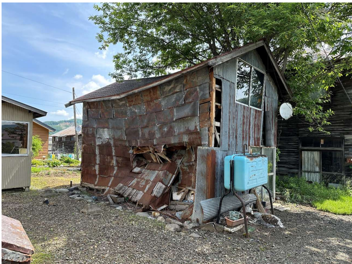
西側壁状況①
