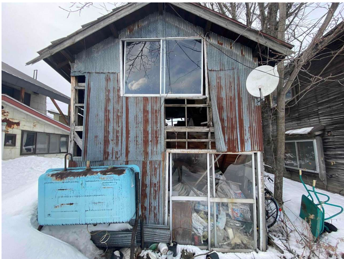
南側壁状況①
