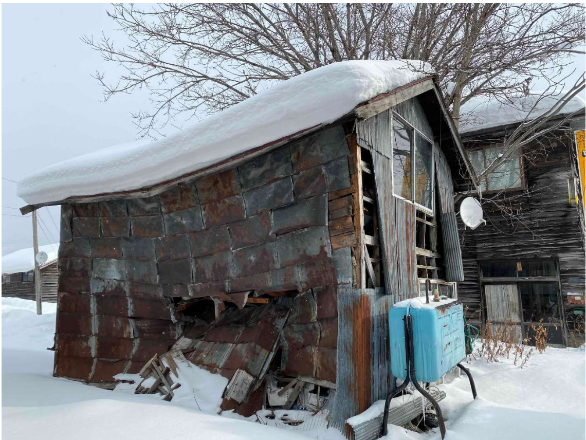
西側壁状況② ※令和 7 年 1 月 1 7 日現在
