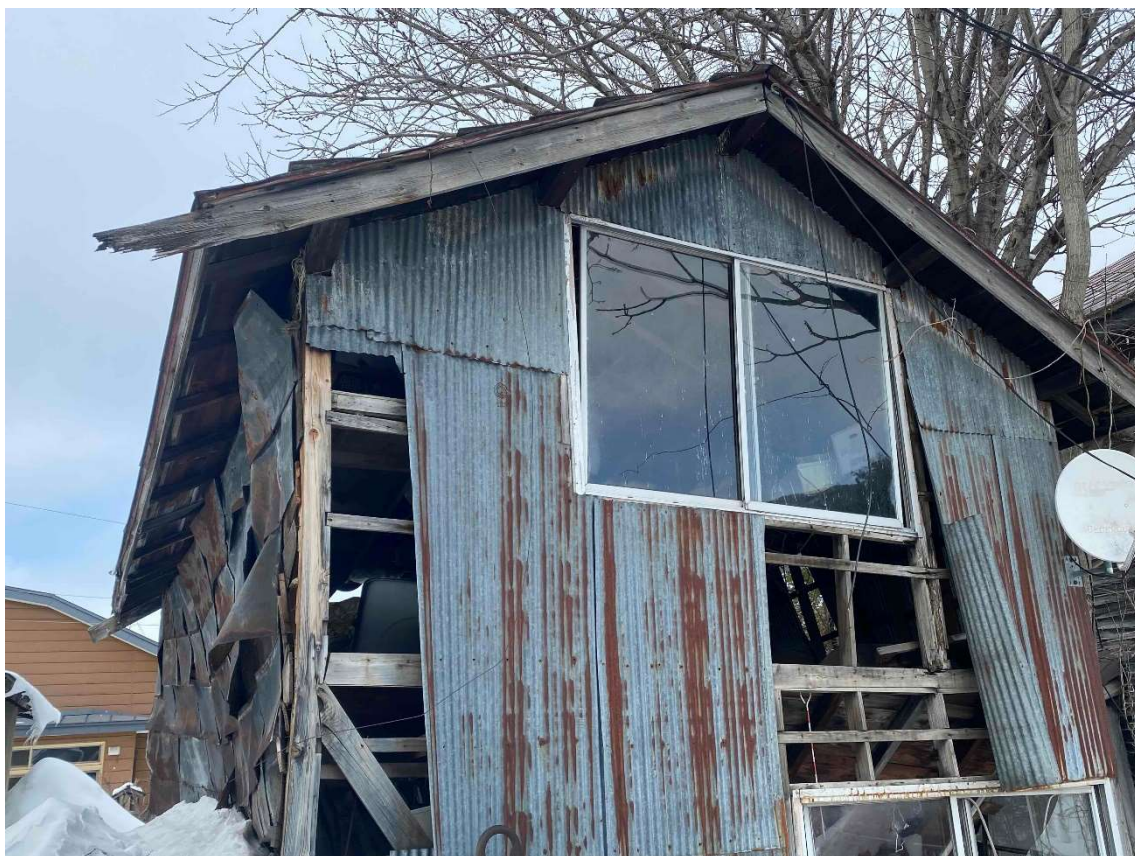
南側壁状況②
