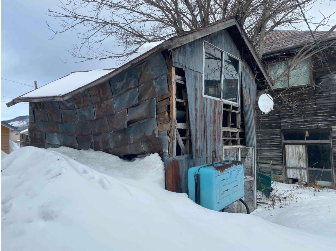
西側壁状況①
