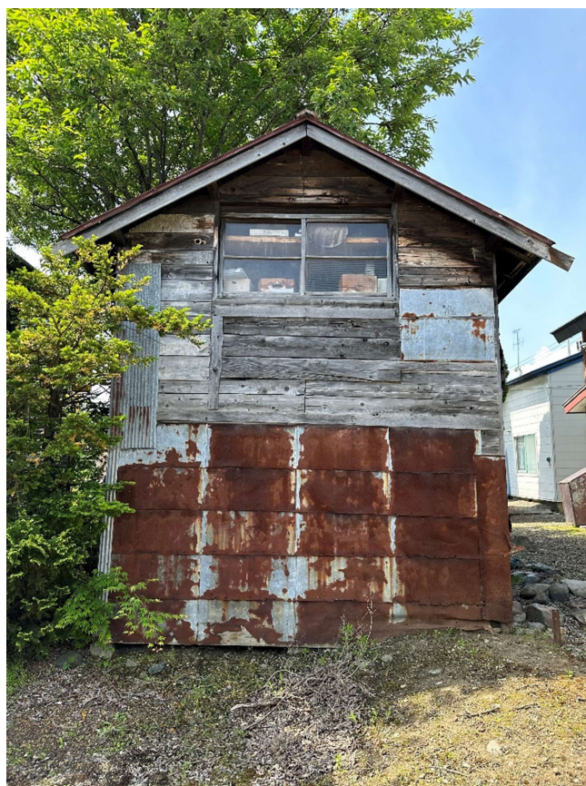
北側状況（建物の傾き等は見られない）
