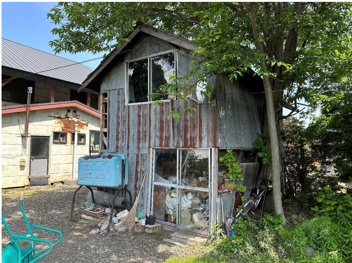
東側壁状況①（南側より撮影）
