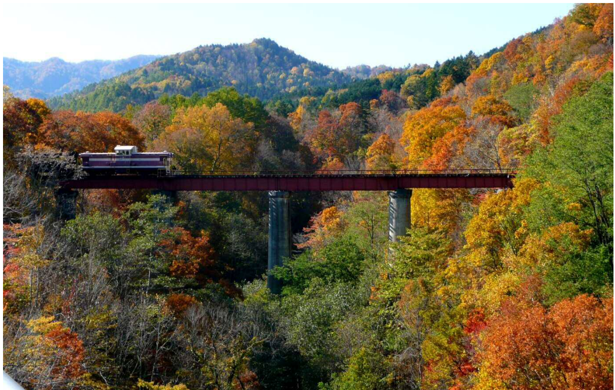
旧三井芦別鉄道炭山川橋梁と線路上に置かれたDD501 (2007年11月撮影)
