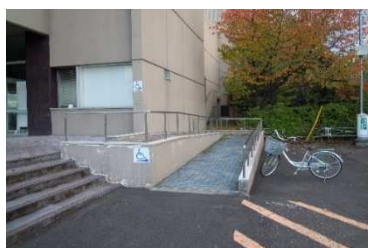
車いす用スロープ
