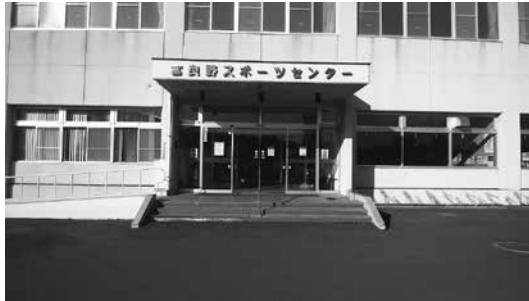
整備が望まれる富良野スポーツセンター
