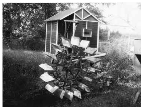
麓郷の白鳥川にある小水力発電施設
