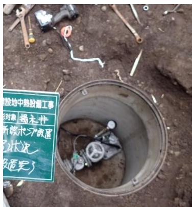
揚水井ポンプ設置状況
