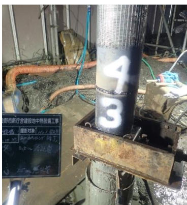
還元井 200A ケーシング施工状況
