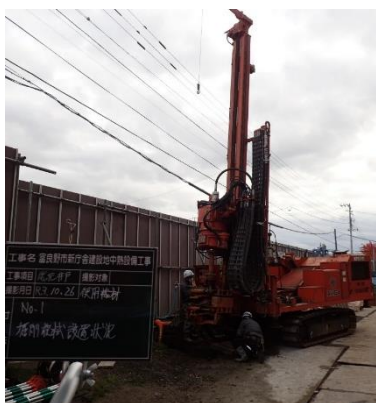
還元井掘削機設置状況
