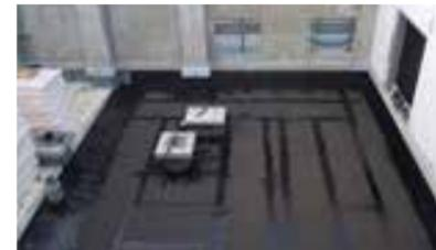
4階屋根アスファルト防水施工
