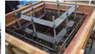
道防災衛星パラボラアンテナの架台取付
