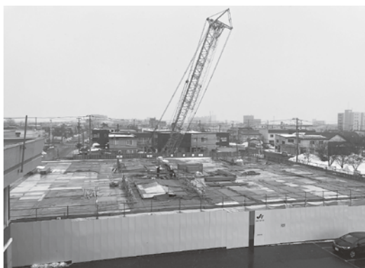
工事の進捗状況
