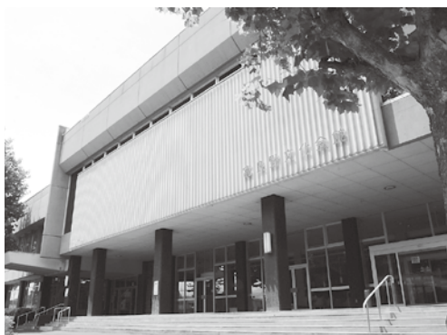
庁舎と合築される文化会館
