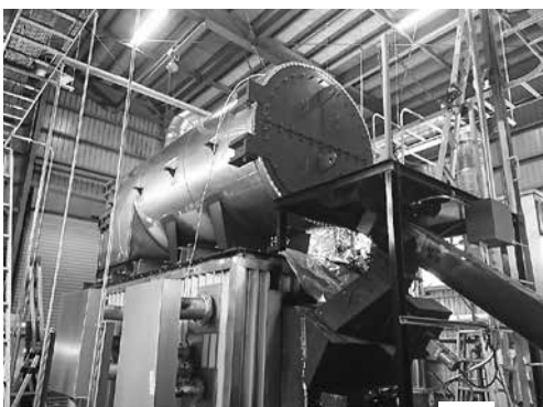
ハイランドふらのRDFボイラー
