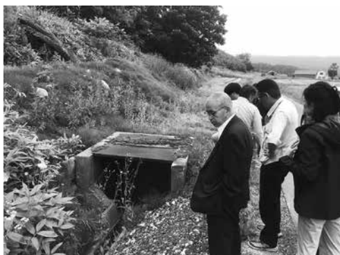
排水路の現地調査
