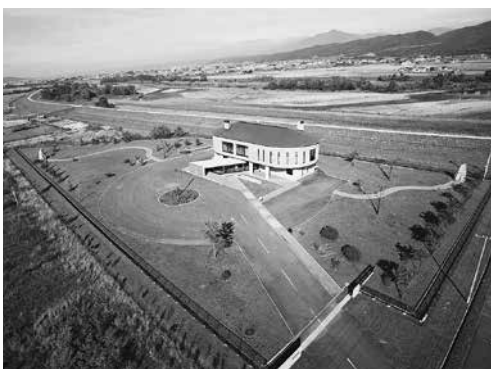
富良野市水源送水場
