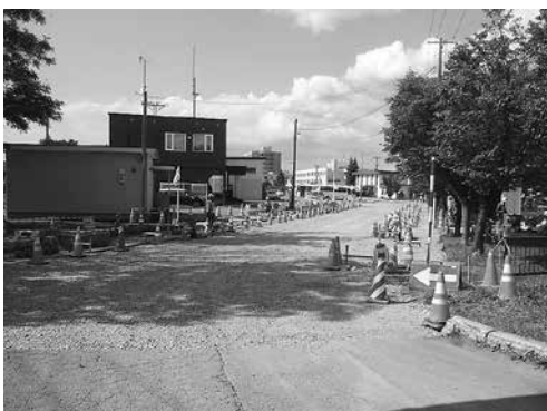
春日・錦町道路改良工事
