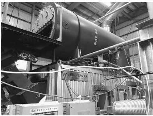
ハイランドふるのに設置されたRDFボイラー
