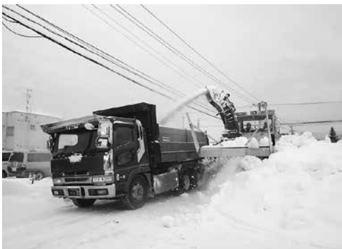
市内の除雪作業
