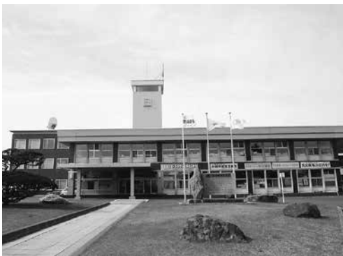
建設から50年経つ庁舎
