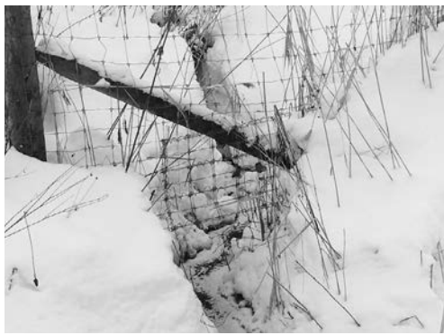
補修するも下部より入る鹿柵
