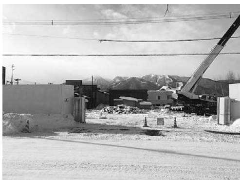
市内の建設中のホテル
