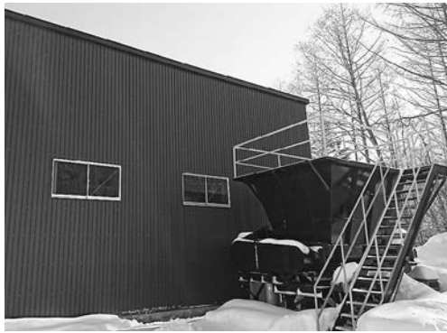
RDFボイラー建屋
