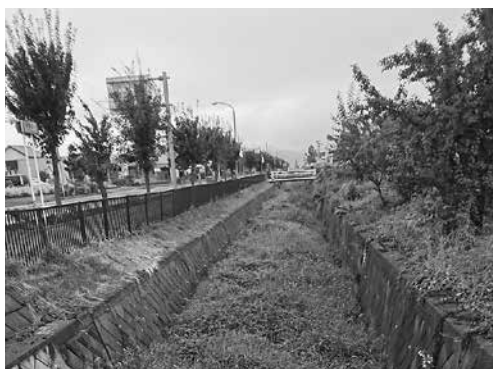
河床の浚渫が望まれる北一号川
