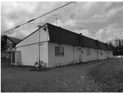
北の峰西団地市営住宅
