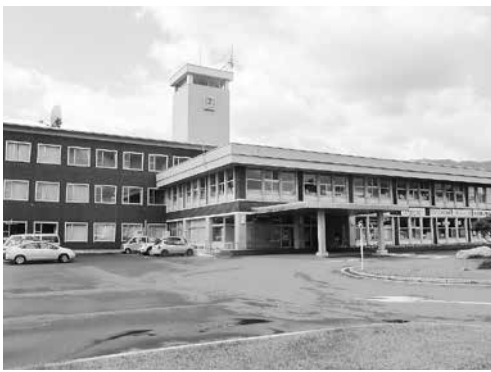
富良野市役所庁舎
