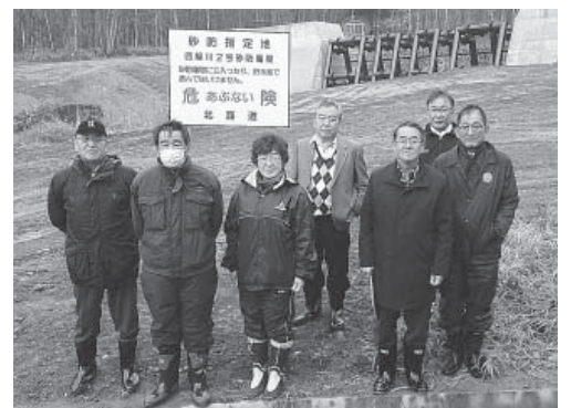
四線川二号砂防堰堤
