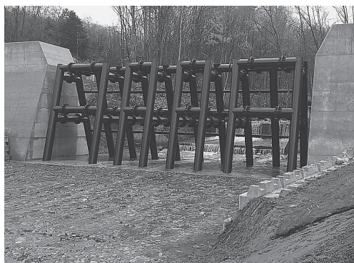
四線川砂防堰堤（ダム）
