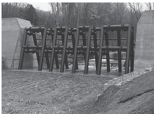
四線川砂防堰堤（ダム）
