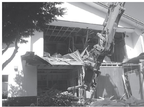
住宅解体作業
