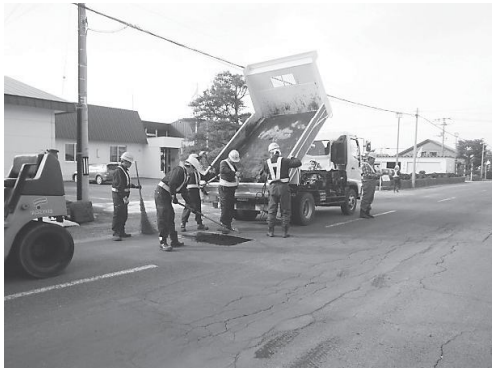
市道補修作業
