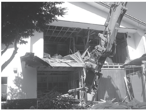
住宅解体作業
