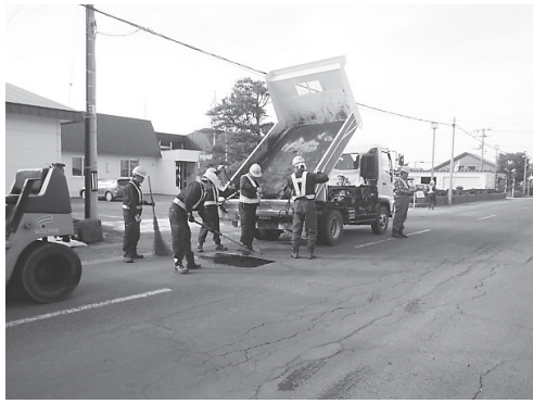
市道補修作業
