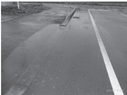
豪雨時の排水路
