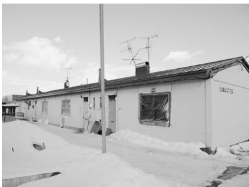
建て替え予定の市営住宅
