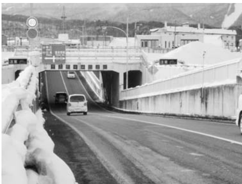
富良野中央跨道橋
