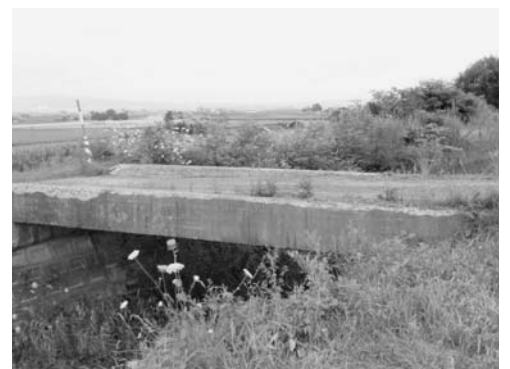
火葬場手前の老朽化した道路橋
