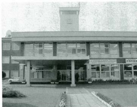
築42年経過した富良野市役所
