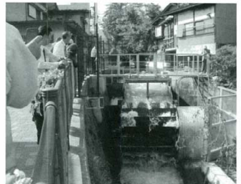
小水力発電所 (山梨県都留市)
