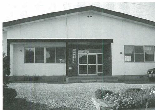
狭隘の緑町学童保育センター
