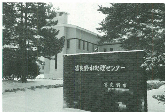
水処理センター
