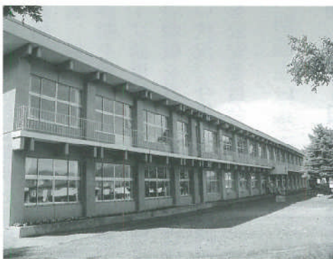
耐震診断を待つ学校施設
