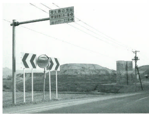
建設中の富良野道路(チーズ工房付近)
