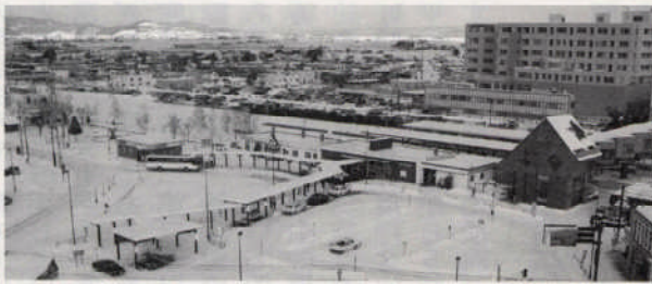
完成間近な駅前広場
