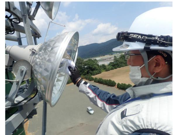
高所作業車に乗り、照明器具の清掃を行う作業員
