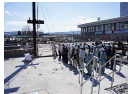
安全祈願の立柱式
