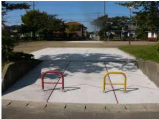
【車両にも耐えるコンクリート版構造に強化
