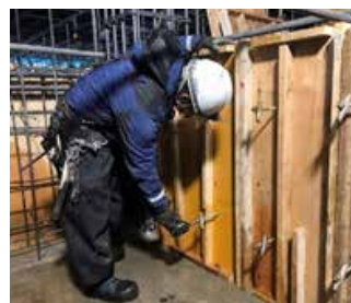
基礎型枠設置状況
