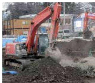
地盤改良工事状況
