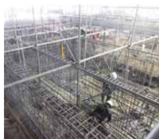
基礎配筋状況
