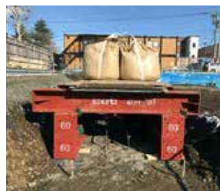
載荷試験状況
