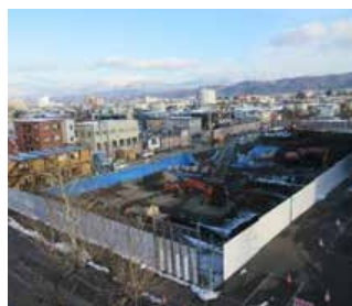
工事敷地全景
