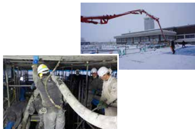
コンクリート打設状況
