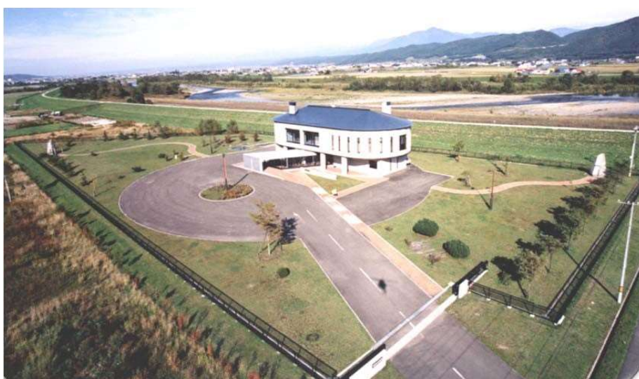
図 中五区水源送水場（深井戸取水施設）
