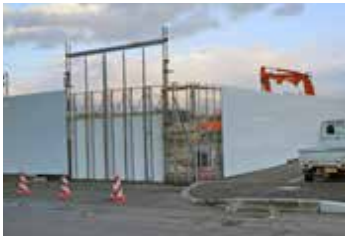
工事見学窓を設置
