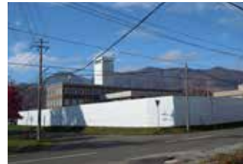
仮設フェンスで仮囲い
