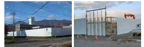
仮設フェンスで仮囲い
