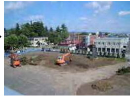
石碑や樹木等の移設・撤去が進んでいる様子（9月9日撮影）
