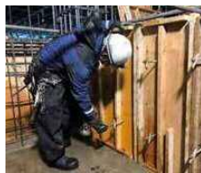
基礎型枠設置状況
