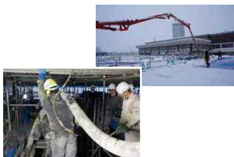
コンクリート打設状況
