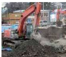
地盤改良工事状況
