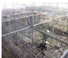
基礎配筋状況
