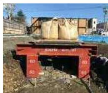
載荷試験状況
