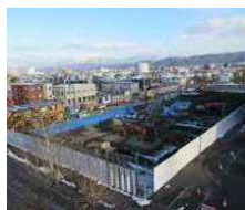
工事敷地全景
