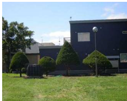
イチイの木4本 平和公園に仮移設し新庁舎再設置
