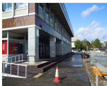
現庁舎の正面玄関 庇撤去完了
