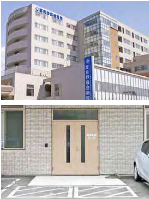
④富良野医療圏で唯一感染病棟を備える富良野協会病院 ⑤病院の東側にある感染病棟の玄関。緊急時はここから直接、陰圧管理された病室に入ることができる
