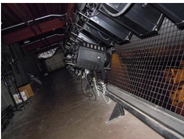
天井裏のキャットウォーク
