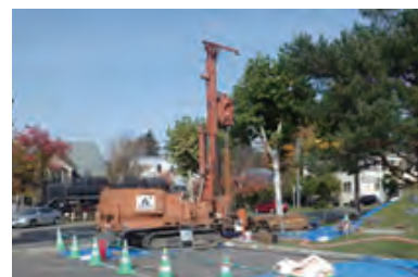
庁舎前庭での掘削状況
