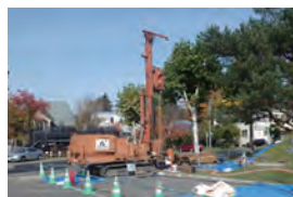
庁舎前庭での掘削状況
